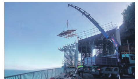
Ende März soll der Tunnel wieder freigegeben werden (Foto/AyPdIC)
