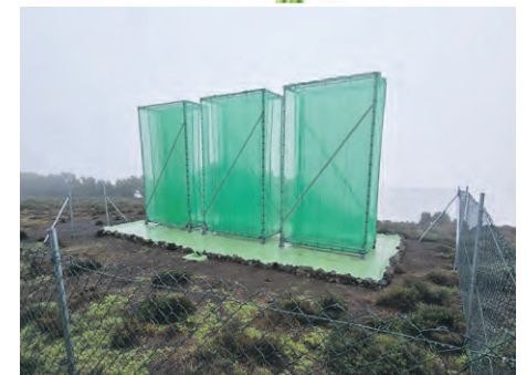
Das Staubecken unter dem Wolkenfänger in Tajusara fasst 300 Kubikmeter (Foto/CabEH)
