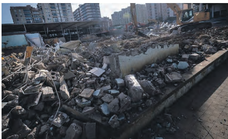
Aus Altem soll etwas Neues entstehen (Foto/ArchivDA)
