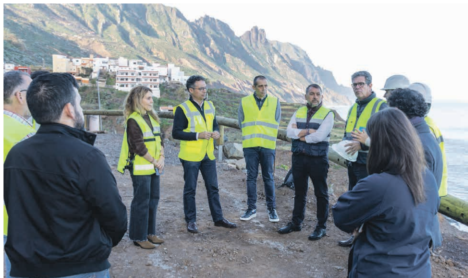
In Taganana kommen die Arbeiten gut voran.
