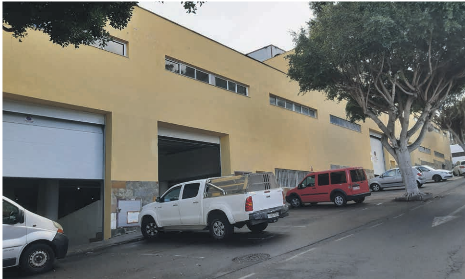
Die neue Lagerhalle in Santa Úrsula (Foto/SV)
