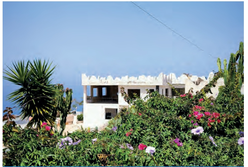
Mittlerweile haben die Renovierungsarbeiten an der „Villa Ola viva“ begonnen (Foto/WC)
