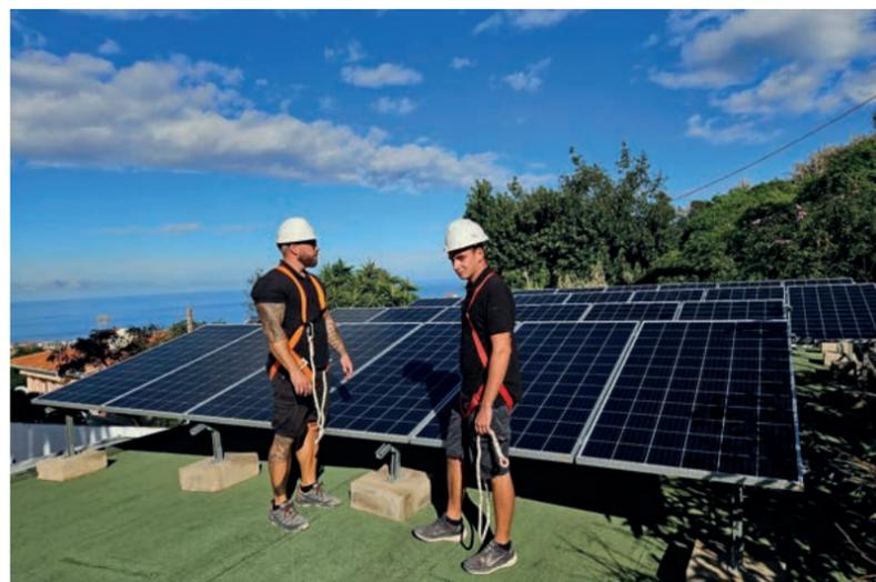
Flachdachinstallation mit Betonlastanlage (Foto/PhotovoltaikTeneriffaS.L.)
